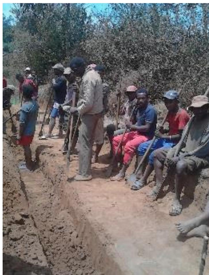
*Semelle des fondations en argile mouillée et compactée.*
